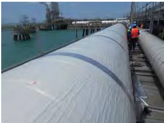
Рисунок 7 – Утепление трубопровода Западное побережье США
