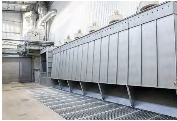
Рисунок 6 – Устройство обеспыливания завальной ямы фирмы PETCUS
